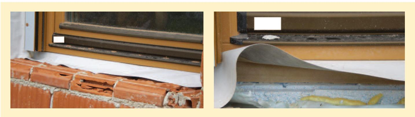
Pokušaj ugradnje prozora  $U=0,70 \text{ Wm}^{-2}\text{K}$  sa trakama za brtvljenje ali zbog nestrucne ugradnje kondenzacija i nekontrolirano prozračivanje su neizbjegžni.
